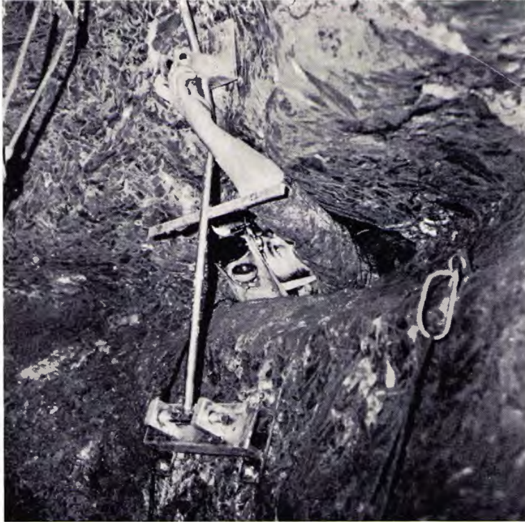
Lavori per la costruzione del cancello, alla strettoia (Foto P. Forti - USB)
