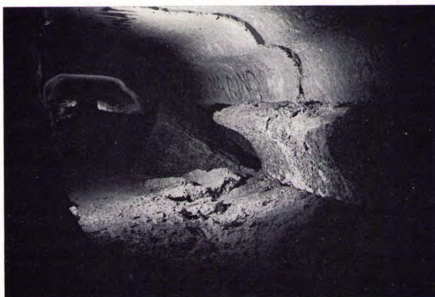
Fig. 2 - Galleria a N.W della Dolina Interna. Scalzamento al piede del grande canale di volta.
