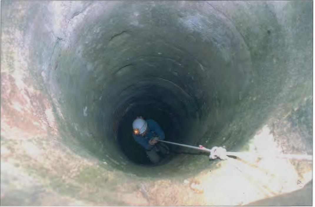
*Fig. 18 - C.2 - Discesa lungo il pozzo. Sono visibili le tacche originali per la discesa*
