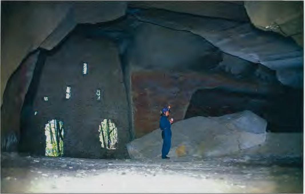
*Fig. 31 - G.V -Il vano iniziale, sulla sinistra il muro di tamponamento dell'ingresso*
