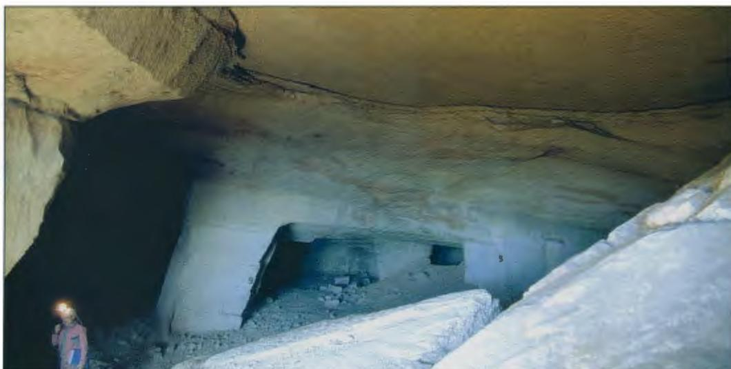
**Fig. 28 - G.III - Distacchi di blocchi dalla volta nella galleria principale.**
