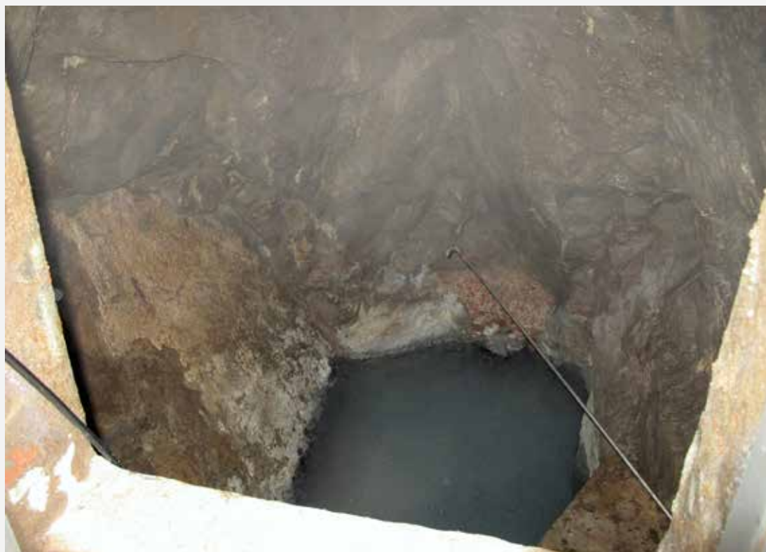
Una delle sorgenti -galleria bassa
