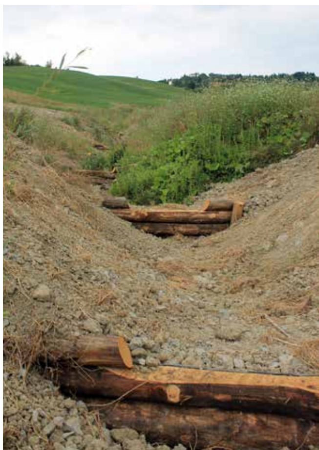
Briglie per ridurre l'erosione ed il trasporto solido nell'ambito dell'azione C 2 sul fondo della valle cieca dell'Acquafredda (Gessi Bolognesi).
