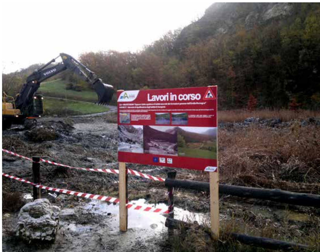
Una fase dei lavori durante l'azione C7 presso le Fonti di Poiano.
