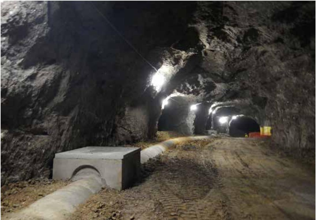
Fig. 2 – Aspetto delle tubazioni all'interno del livello intermedio della ex Cava Prete Santo (dopo alcuni recenti lavori di sistemazione e sostituzione) con cui vengono raccolte le acque del Rio Acquafredda presso il sifone per essere addotte, per gravità, fino al torrente Savena.
