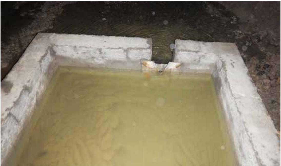
Fig. 6 – Stramazzo sul canale di scarico delle acque del rio Acquafredda al livello intermedio per la misura delle portate.
