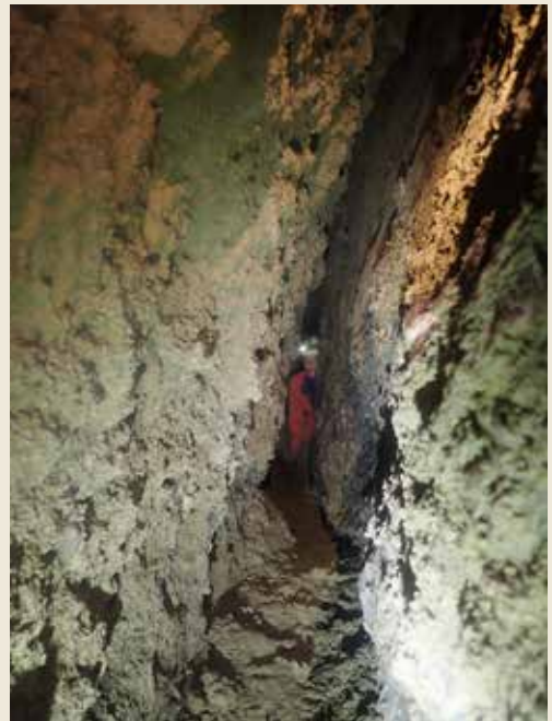
La strettoia da percorrere prima dello svuotamento del canale di volta adiacente (foto di Massimo Dondi)
