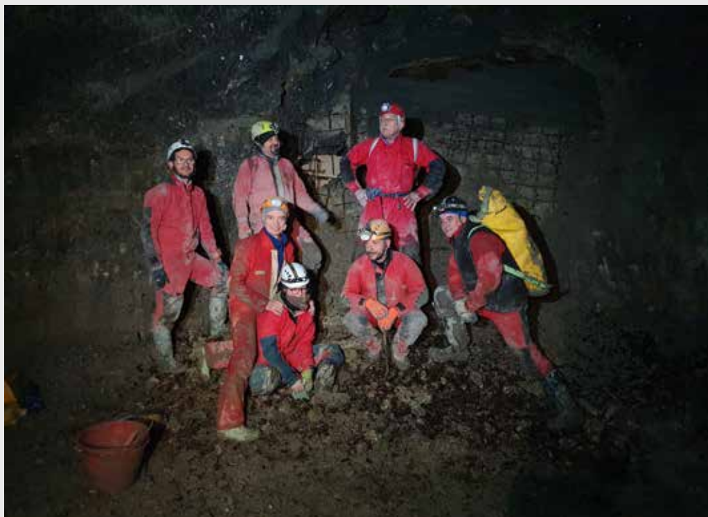
Parte dei componenti dell'opera di consolidamento del muro (foto di Nevio Preti)
