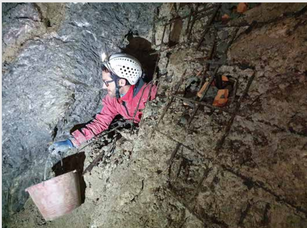
Lavori attraverso il muro (foto di Massimo Dondi)
