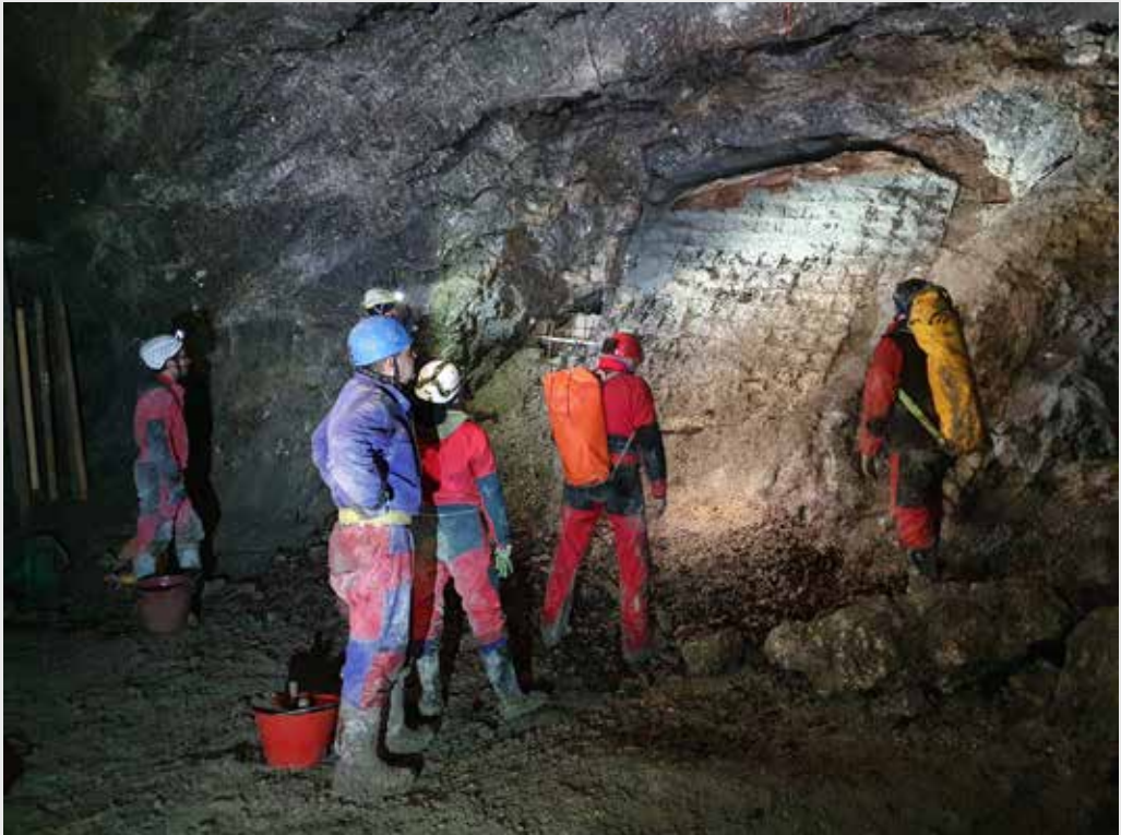
Il Muro del Pianto in fase di consolidamento (foto di Massimo Dondi)
